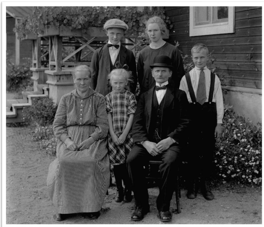
Familjen Granlund, Ställberget. Sittande: Johanna Granlund, f. 1874. Rut Granlund, f. 1915. Per August Granlund, f. 1871. Stående: Sven Granlund, f. 1907. Elin Granlund, f. 1903. Elis Granlund, f. 1913. (De två äldsta barnen, Hilma och Alma inte med på bilden) Foto: Emil Göstas. Grangärde Fotoklubb.
