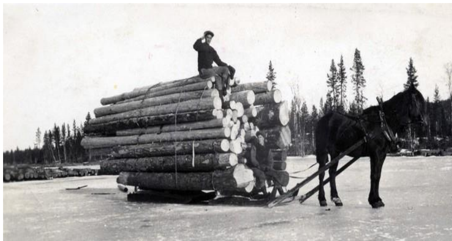
Vid körning på sjö med blankis finns möjlighet att lasta upp mot 16 löskubik enligt bilden nedan. Vikten blir drygt 10 ton. Skogsbruk i
