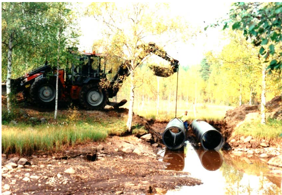
Byte av vägtrummor i Tansbäcken den 21 september 1999. Foto: Kjell Vadfors.
